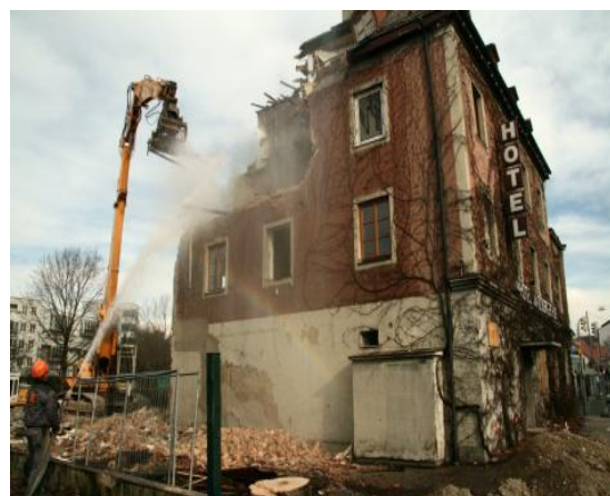
Abrissarbeiten 2009 / Foto Münchner Webespiegel
