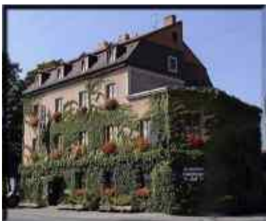
Zeigt das Gebäude kurz vorm Abriss ( Foto Privat )
